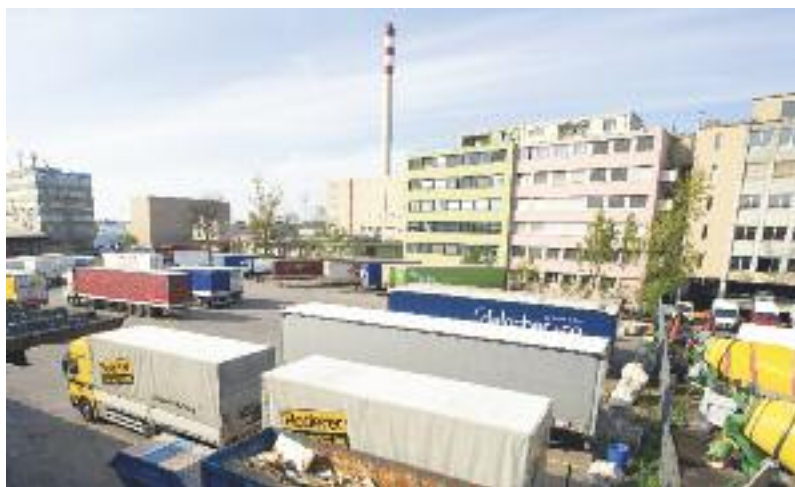
Die Deponie «Feldreben» befindet sich in Muttenz zwischen Kriegacker- und Hofackerstrasse in Nachbarschaft mit Wohn-, Schul- und FHNW-Gebäuden.
