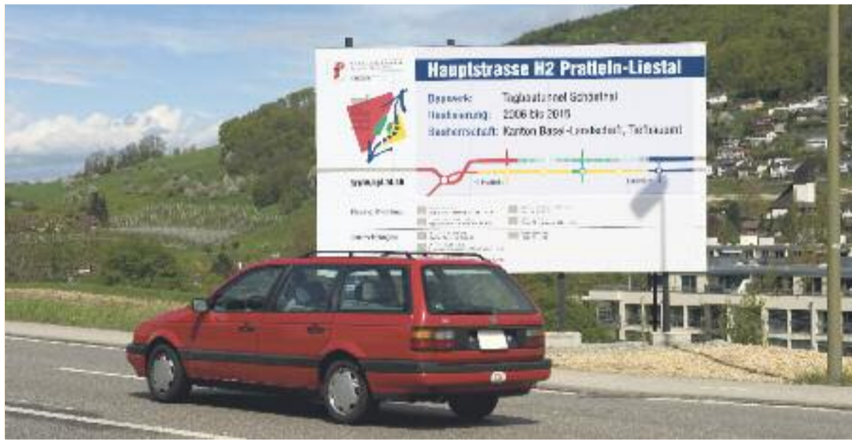
Der Bau der H2 schreitet planmässig voran – die Kosten sind im Griff.
