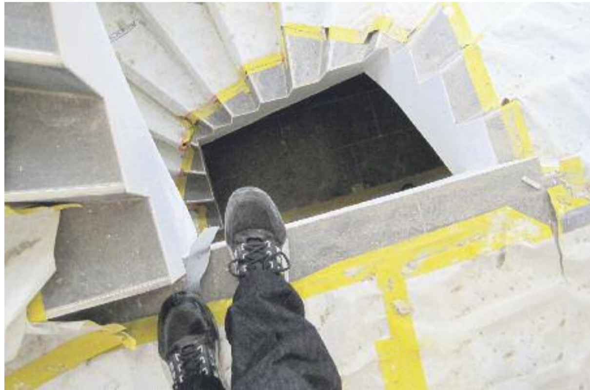
Fehlende Treppengeländer in Neubauten sind häufig Realität. Ein falscher Schritt – und ein Bauarbeiter könnte vier Stockwerke tief stürzen und sich dabei schwere Verletzungen zuziehen.
