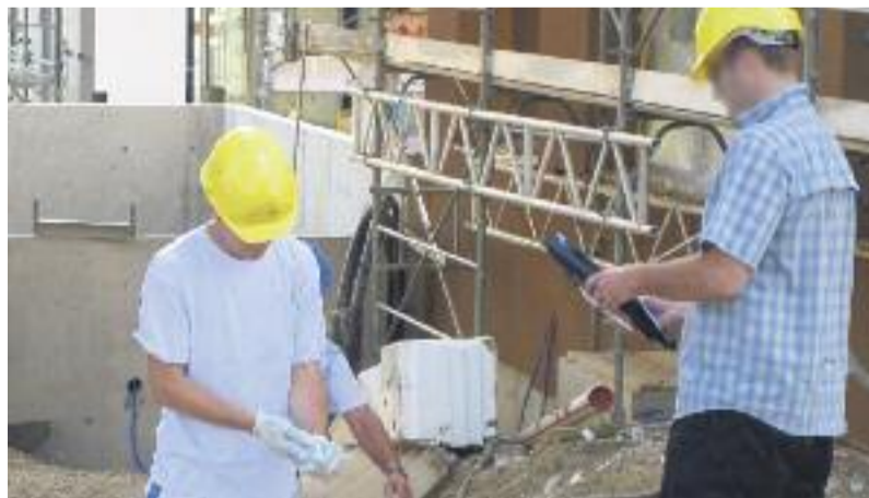
Baustellenkontrollen der ZPK tragen im Baselbiet massgeblich dazu bei, Lohn- und Sozialdumping wirksam zu bekämpfen.
